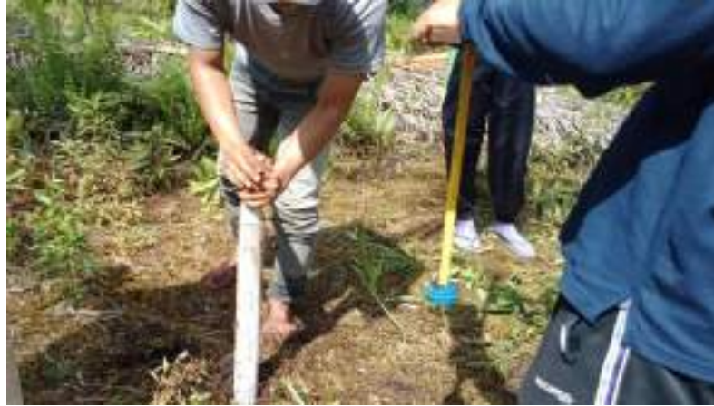
Gambar 3.14 Pemasangan Pipa PVC 2” untuk Melapisi Dinding Sumur Uji
