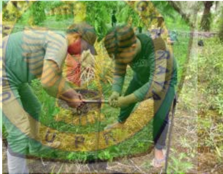
Gambar 3.13 Pembuatan Sumur Uji dengan Bor Gambut Eijkelkamp
